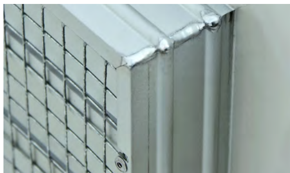
Trafo Ventilasjonsrist sett fra baksiden
