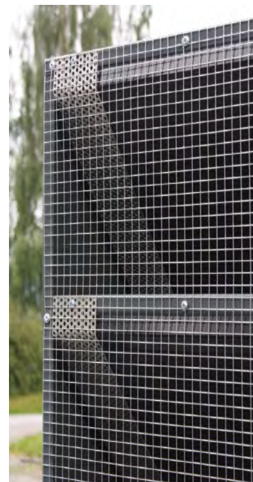
Lydreduserende Ventilasjonsrist sett fra baksiden.
